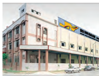
Главный офис и 1й завод
