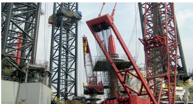
Береговое строительство. Строительство подъемных платформ
